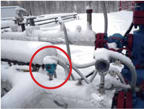
АИР-10SH в реальных условиях эксплуатации на объектах транспортировки газа
