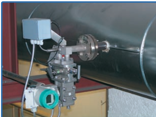
Измерение потока пара с прямо установленным передатчиком и непосредственно интегрированным датчиком измерения температуры.
