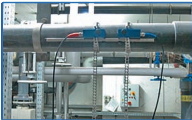
Счетчик тепловой энергии в городских коммунальных службах города Мюнхен
