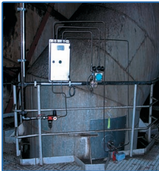
DF25 с системой продувки воздуха низкого давления в паропроводе для сжигания газа с высоким содержанием частиц после подогрева воздуха.
