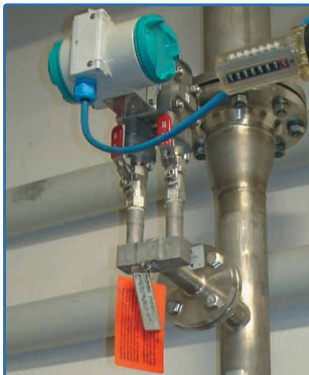
Использование deltaflow для измерения потока биогаза
