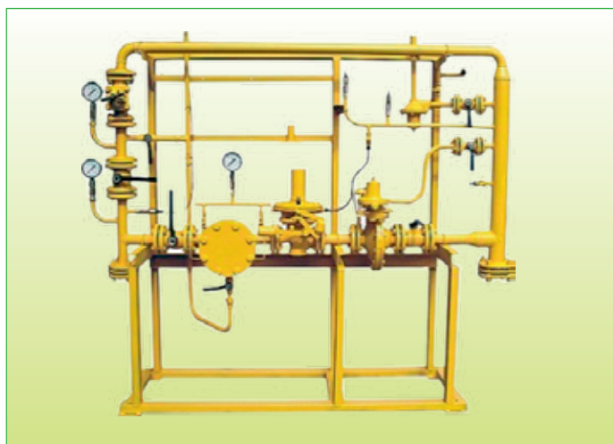
Газорегуляторная установка на раме
