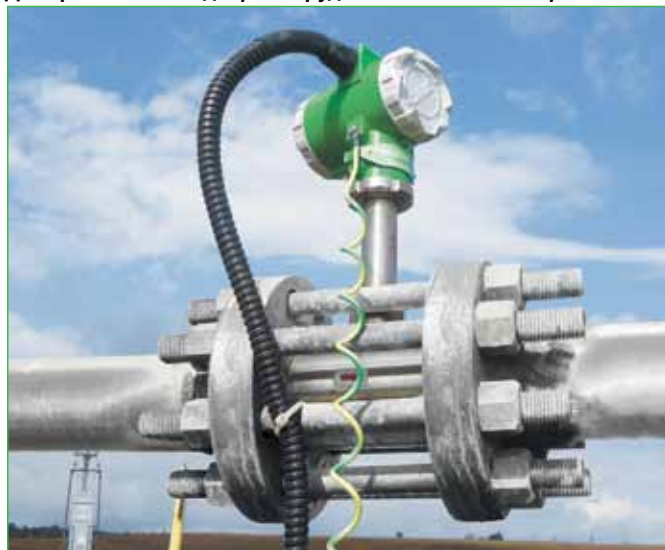
Вихревой расходомер высокого давления ЭМИС-ВИХРЬ 200 ППД на объекте
